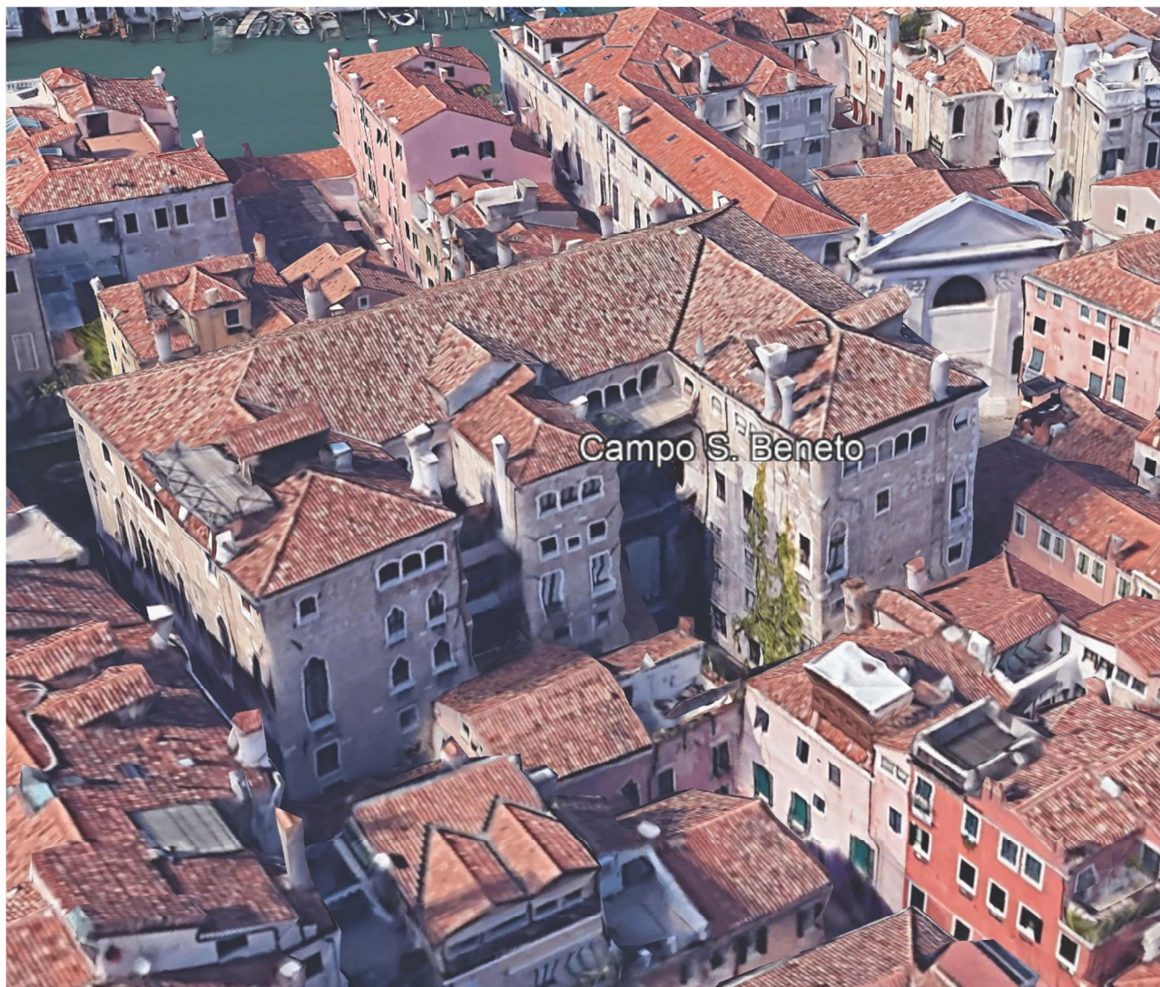
foto 1 - vista prospetto laterale
