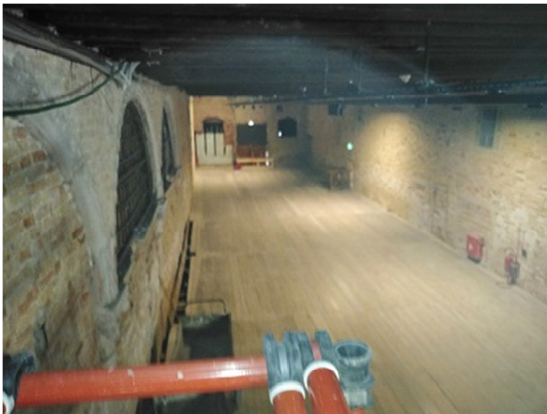
foto 68 - vista da trabatello per verifica puntellazione
