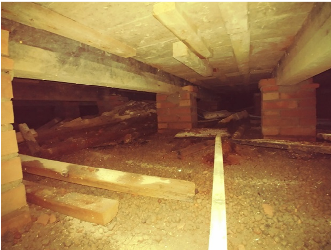
foto 57 - vista situazione sottopavimento
