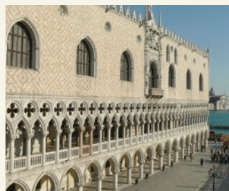
Palazzo Ducale, facciata lato Piazzetta
