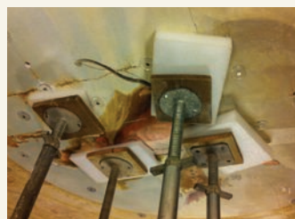
Particolare della zona centrale durante le operazioni di presidio funzionali a garantire la sospensione temporanea del soffitto ad incannucciato che presenta fenomeni di cedimento
