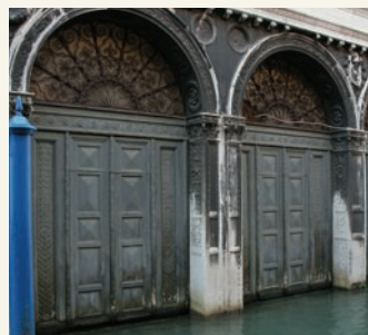
I portoni lignei ottocenteschi prima dello smontaggio operato nel 2007 in occasione dei restauri della grande facciata rinascimentale
