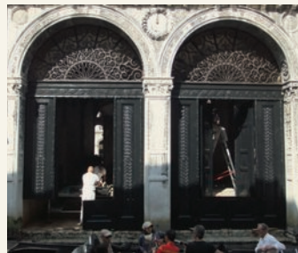
Veduta dei due portoni gemelli già restaurati durante le operazioni di rimontaggio in sede. È visibile il nuovo meccanismo di apertura selettiva delle varie parti conseguente al taglio delle porzioni inferiori ed all'inserimento di nuove porzioni indipendenti
