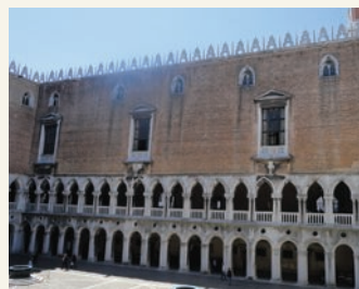
Veduta della facciata ovest prospiciente il cortile interno
