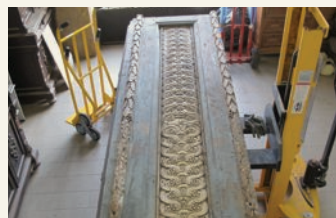
Veduta dello stato di fatto di una delle posterne finemente decorate in bassorilievo, con evidenza dei fenomeni di degrado esistenti
