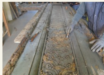
Una delle fasi di lavorazione durante il restauro già eseguito dei portoni gemelli a quelli oggetto del futuro intervento
