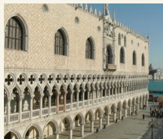
Palazzo Ducale, facciata lato Piazzetta
