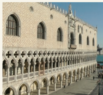
Palazzo Ducale, facciata lato Piazzetta
