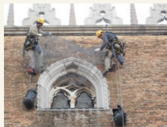
Particolare dell'intervento di presidio effettuato sui grandi finestroni con i restauratori in fune
