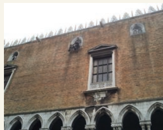
Veduta della facciata durante le operazioni di ispezione e messa in sicurezza effettuate con i restauratori abilitati al lavoro in fune
